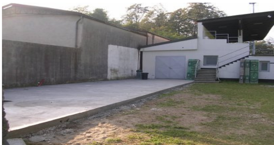
Lavori in corso di realizzazione al Campo Sportivo Comunale di Ornavasso
