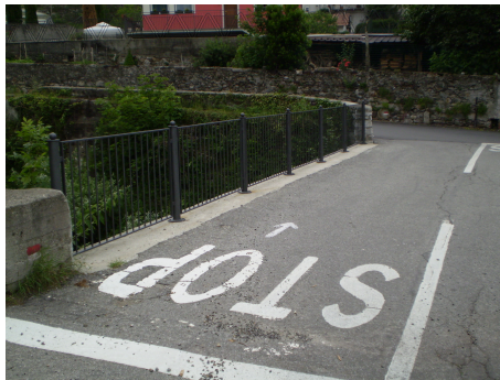
Rifacimento della segnaletica orizzontale a Ornavasso e Migliandone e tinteggiatura delle ringhiere dei ponti e della Casa dell'Anziano.
