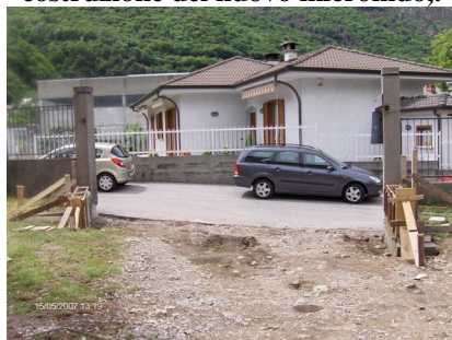
Con il rifacimento della scala anti-incendio alle scuole elementari sistemazione dell'accesso al cortile.
