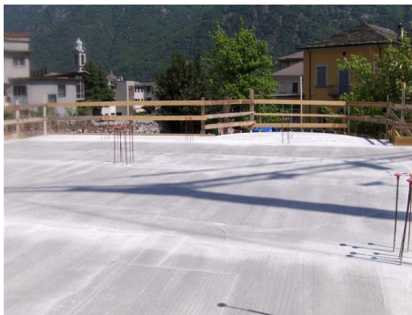
Nella foto l'avanzamento dei lavori di costruzione del nuovo micronido.
