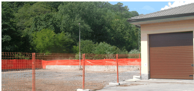
Nella foto l'area cantiere presso i magazzini comunali a Ornavasso per la sistemazione del piazzale
